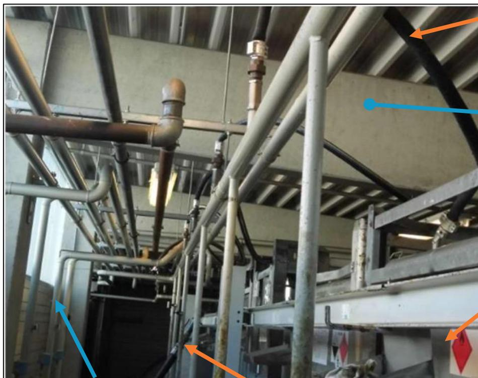
Tubería de igualación de presión conectada entre IBC y ventilación en el techo
