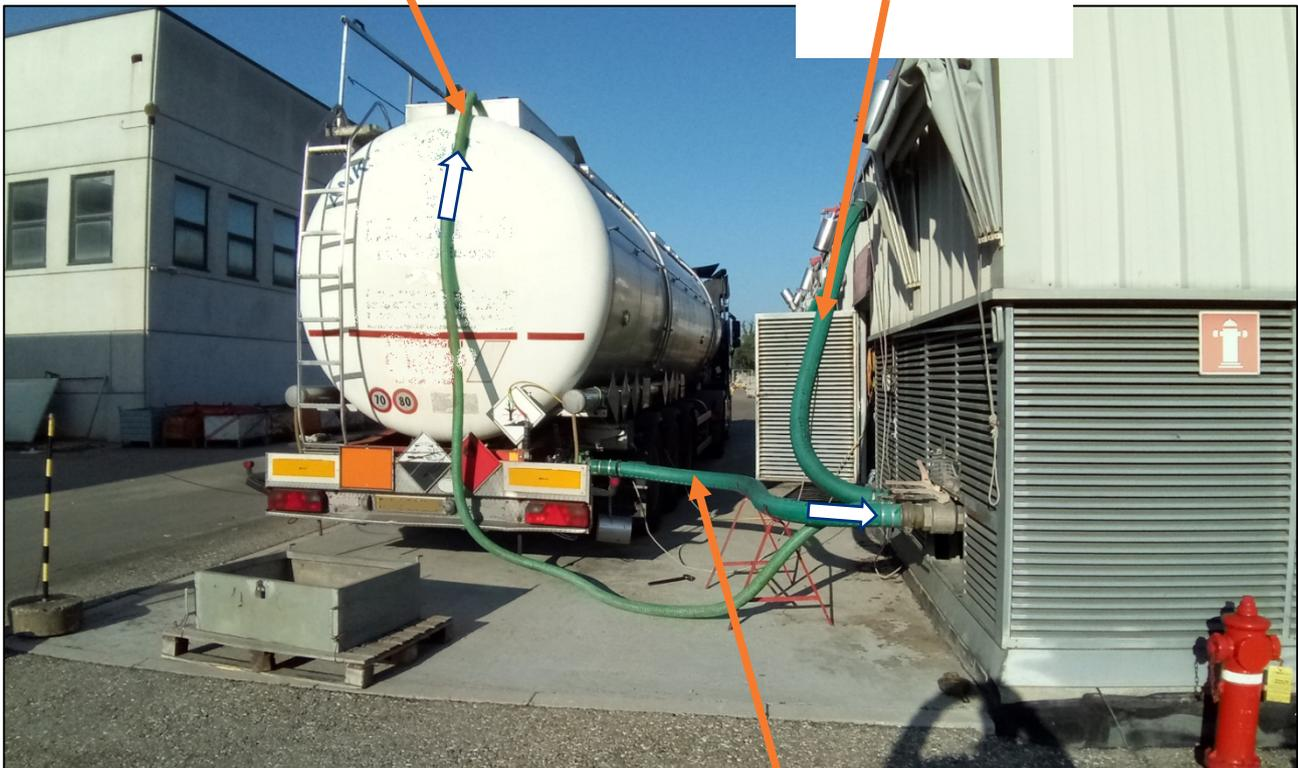
Entladerohre zum Überführen von Lackiermasse aus dem Tankwagen in den Lackiermassenlagertank
